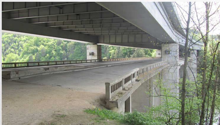
Technická zajímavost dvoupatrový dálniční most u Píště. autor: Radek Vondrák
